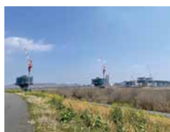
建設が進む新名神高速道路。筆築用ヨシへの影響を避けるため、間隔が広くとられた橋脚。
