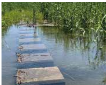
ヨシ原に設置された導水路
